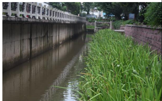
通园溪河道防护
