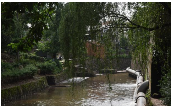
通园溪终点护岸工程
