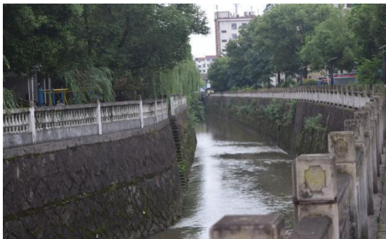
通园溪河道堤防工程
