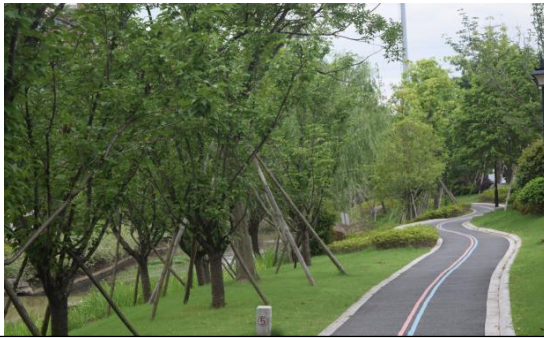
边坡管线敷设带绿化
